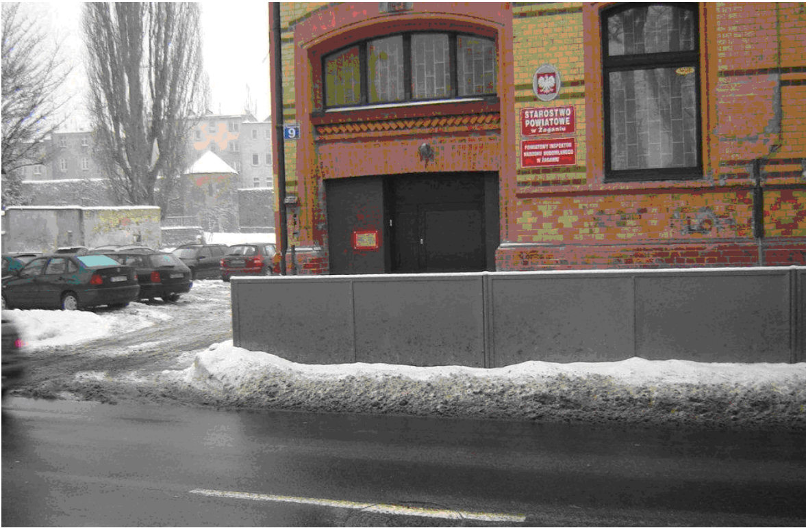
Zdjęcie nr 1 - Przykład ekranów ochronnych z blachy ocynkowanej
