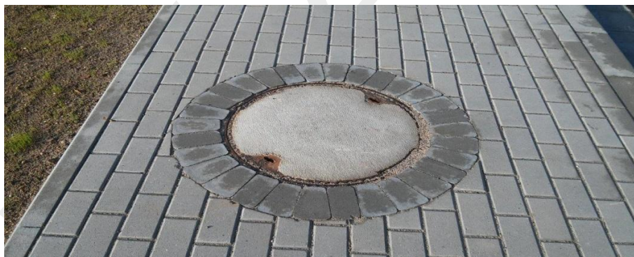
Fot. Sposób układania kostki brukowej betonowej wokół włączów usytuowanych w chodnikach.
