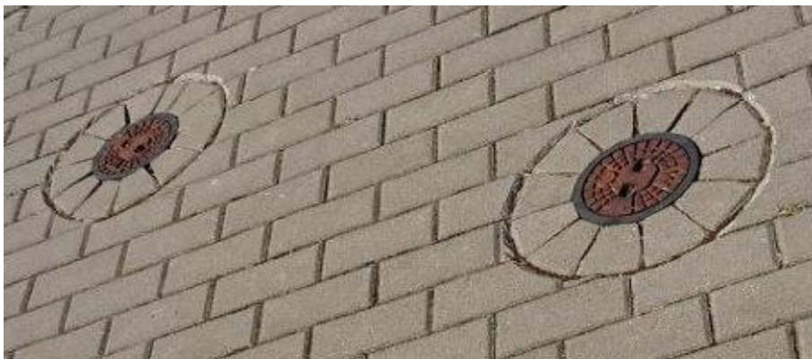
Fot. Sposób układania kostki brukowej betonowej wokół zasuw usytuowanych w chodnikach.
