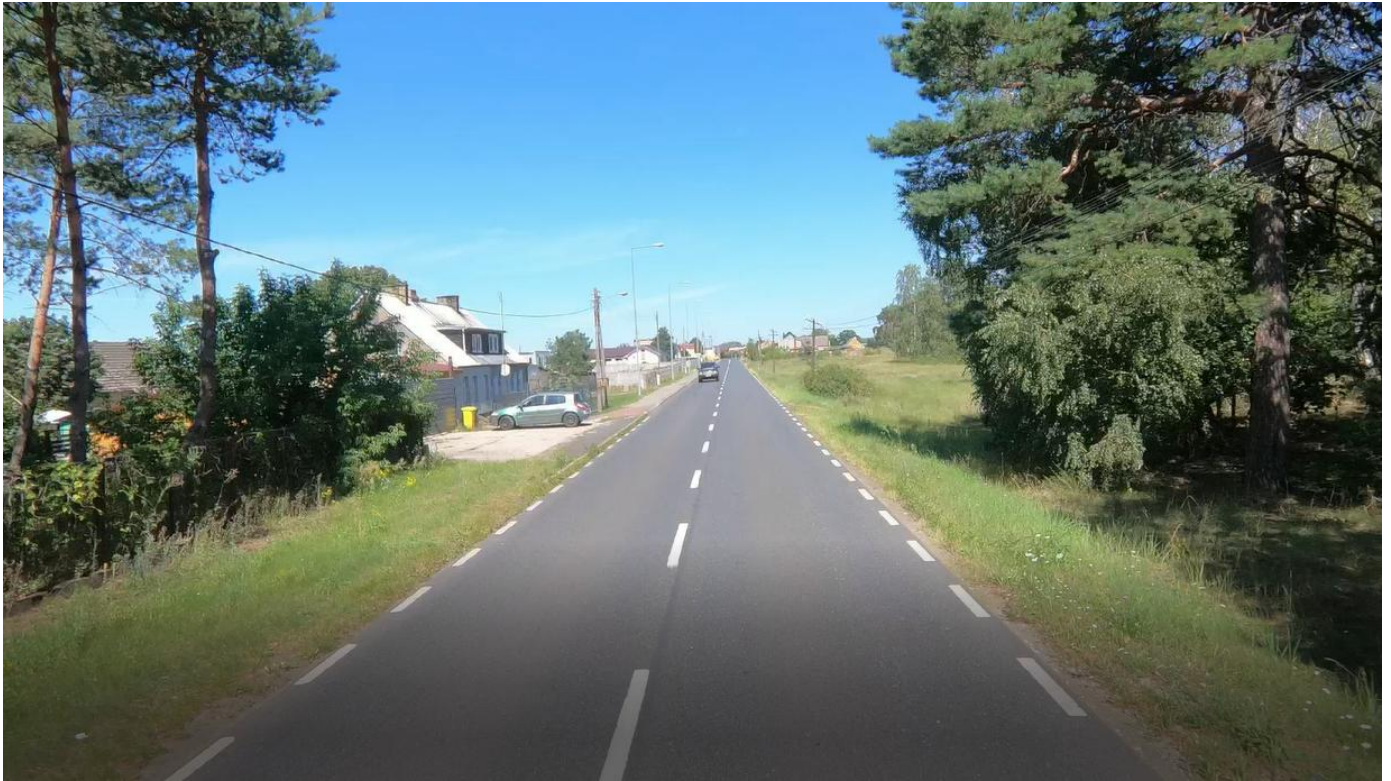
Zdjęcie nr 1 - lokalizacja ustawienia radarowego wyświetlacza prędkości wraz z zasilaniem energią słoneczną na słupie wsporczym
