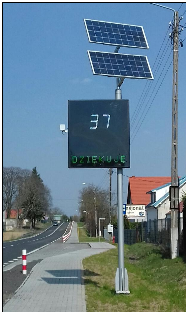
Zdjęcie nr 3 - zdjęcie poglądowe radarowego wyświetlacza prędkości wraz z zasilaniem energią słoneczną na słupie wsporczym.
