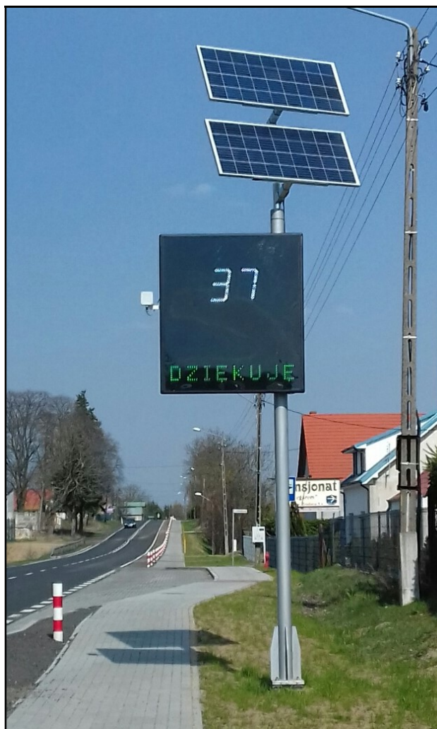
Zdjęcie nr 3 - zdjęcie pogładowe radarowego wyświetlacza prędkości wraz z zasilaniem energią słoneczną na słupie wsporczym.
