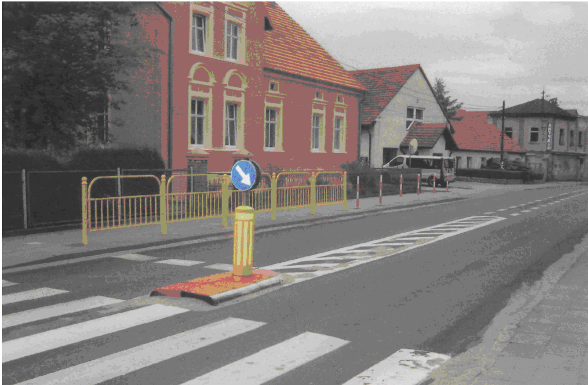
Zdjęcie nr 2 - Przykład barierek stalowych ocynkowanych ogniowo i malowanych proszkowo na kolor żółty typu MABO 3
