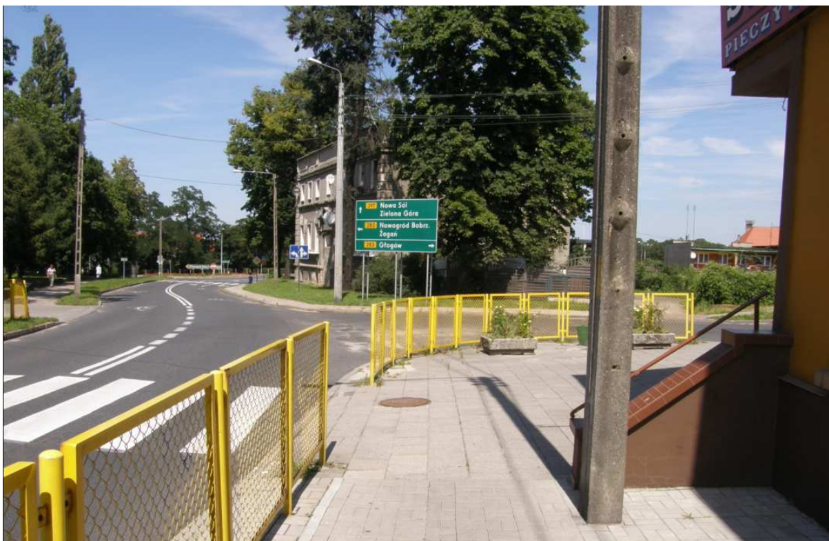
Zdjęcie – 4 - stanu istniejącego wlot od Szprotawy – ul. Szprotawska droga woj. nr 297.
